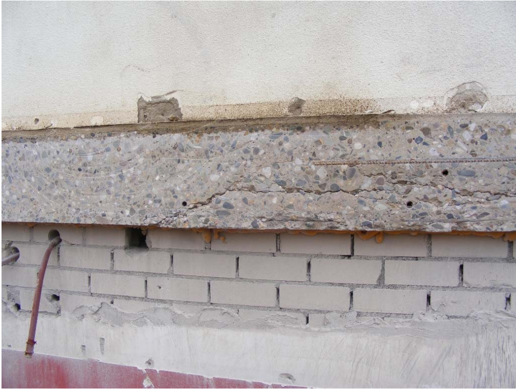
Foto 10: 1 e verdieping tussen as c en e.
