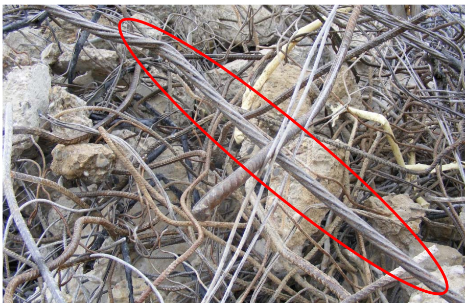
Foto 28: VZA-kabel in puin
