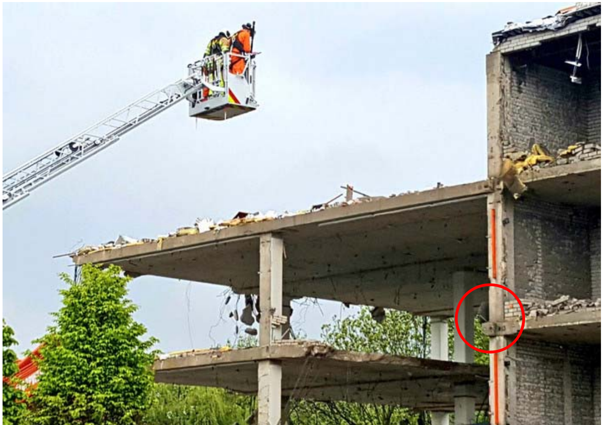
Foto 37: Zaagblad ter hoogte van de 2 e verdiepingvloer (foto: AD)
