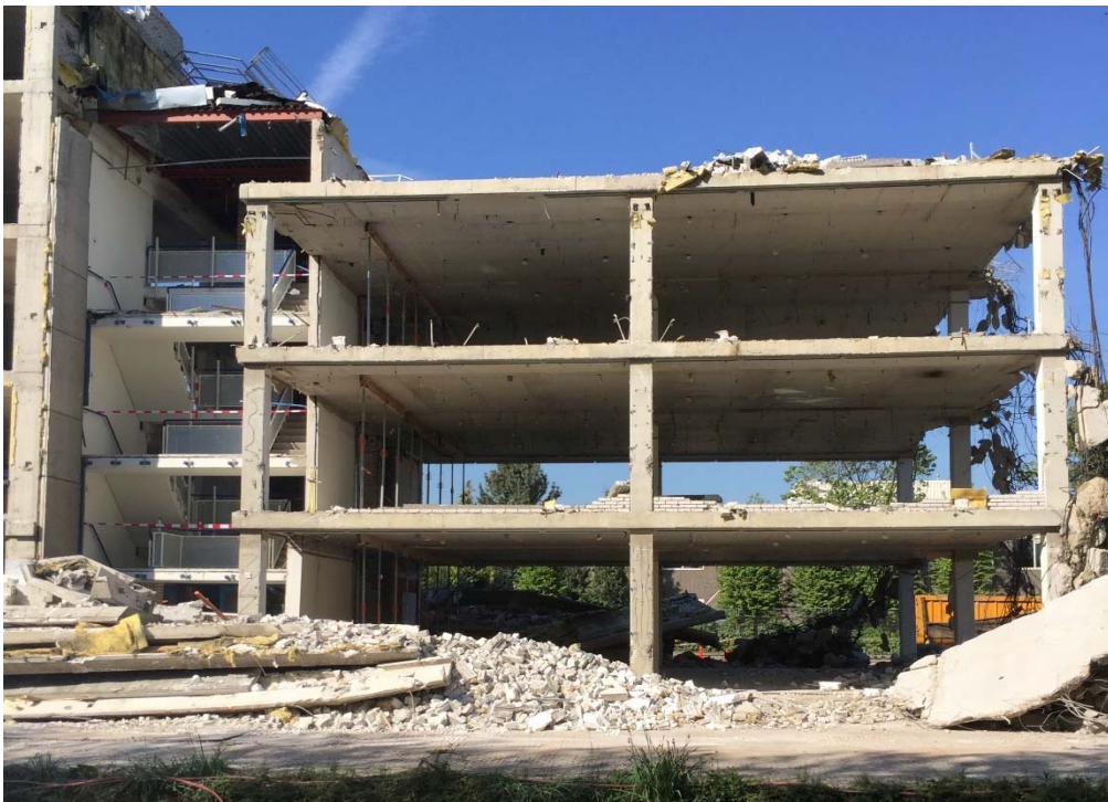
Foto 2: Rij stempels op iedere bouwlaag aanwezig (foto 11-5-2017) [13].
