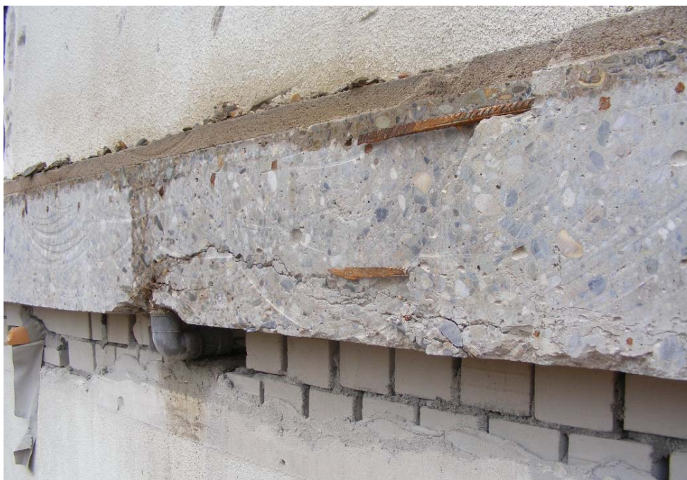
Foto 13: 2 e verdieping, tussen as c en e.
