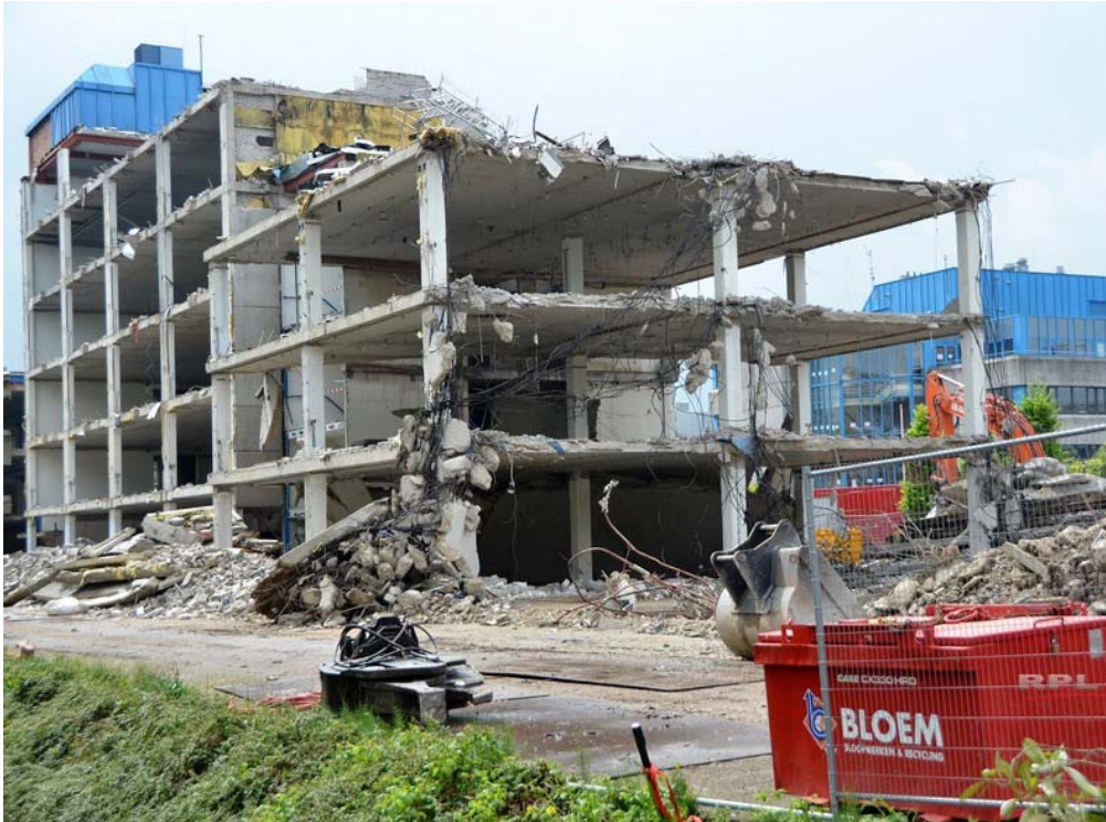
Foto 4: Vloerranden aan zijde Blekerijlaan niet bezweken (foto: RPL/Anno Visser).
