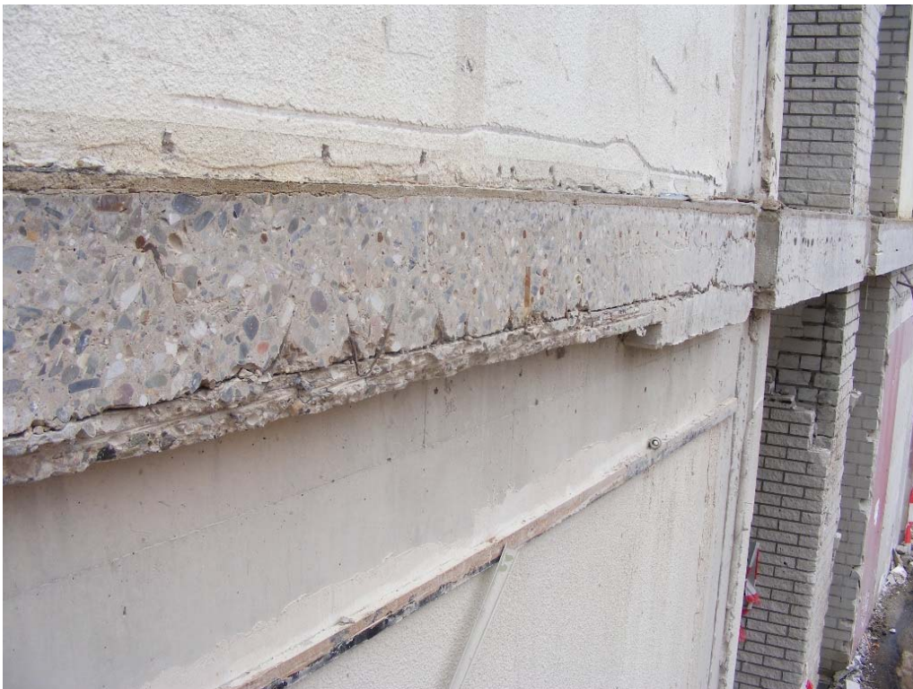
Foto 11: 1 e verdieping tussen as a en c.
