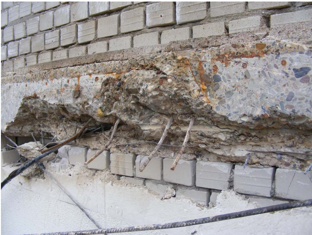
Foto 17: 3 e verdieping, naast randstrook op as e.
