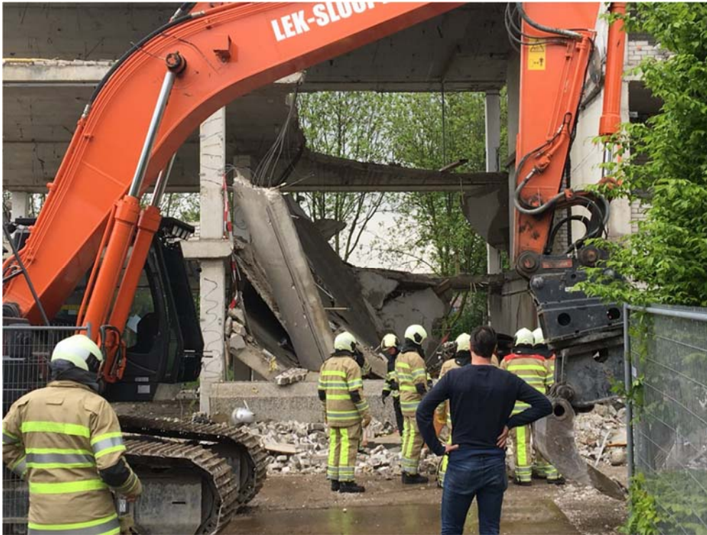
Foto 29: Bezwijkbeeld van bezweken vloergedeelten (bron: internet).
