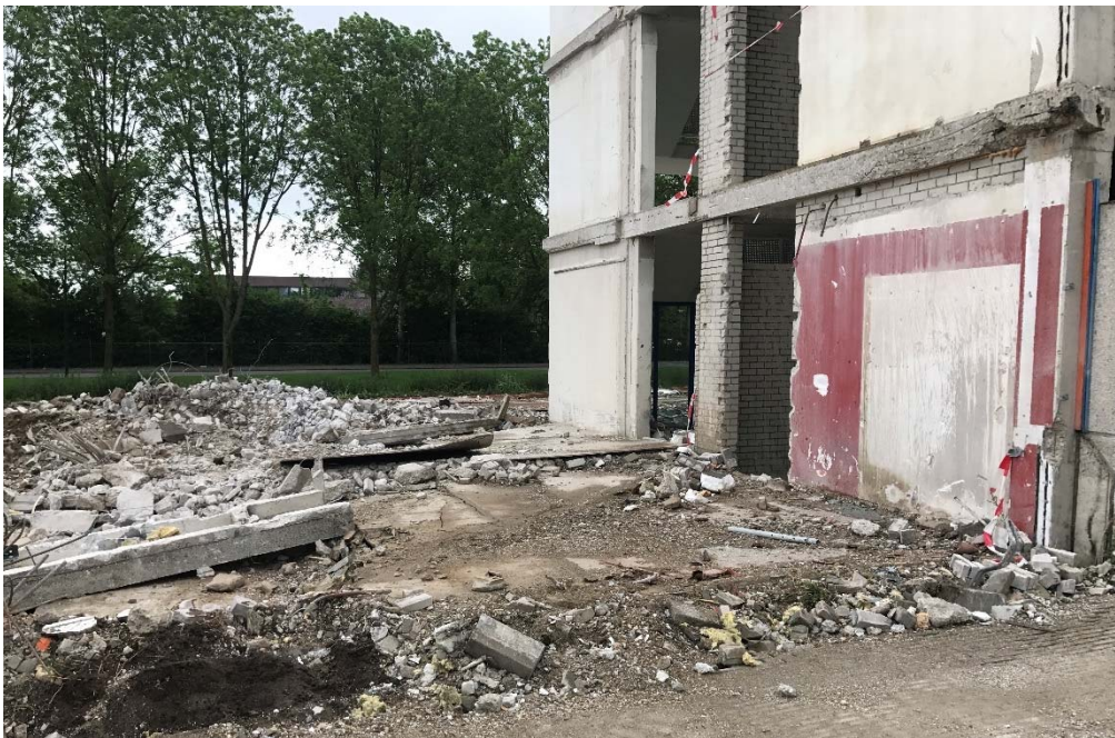
Foto 26: Begane grondvloer na verwijdering van puin en rijplaten.
