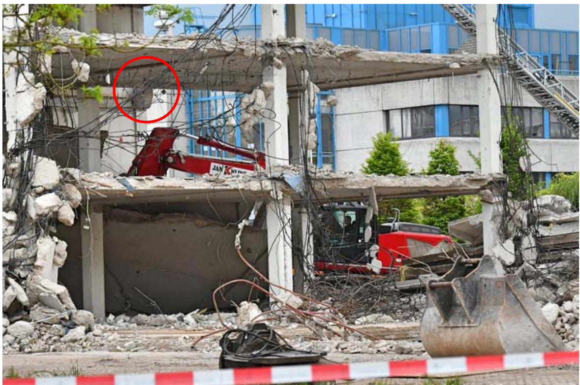
Foto 38: Zaagblad gezien vanaf de zijde van de Blekerijlaan (foto: AD)
