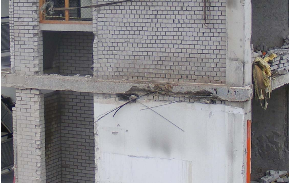
Foto 16: 3 e verdieping, naast randstrook op as e.
