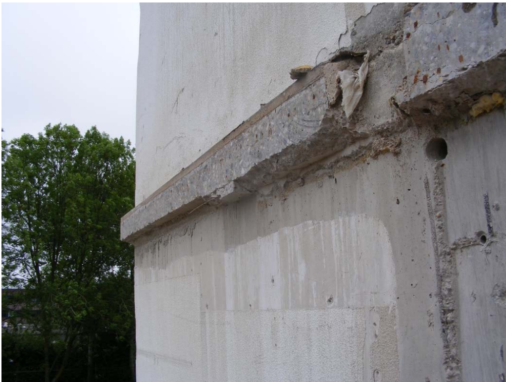
Foto 15: 2 e verdieping, tussen as a en c.
