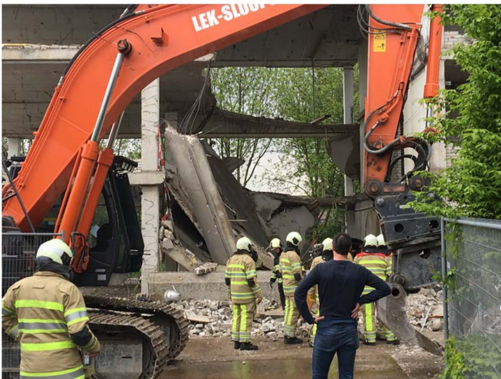
Foto 5: Bezwijkbeeld van bezweken vloergedeelten (foto: Woerden TV).
