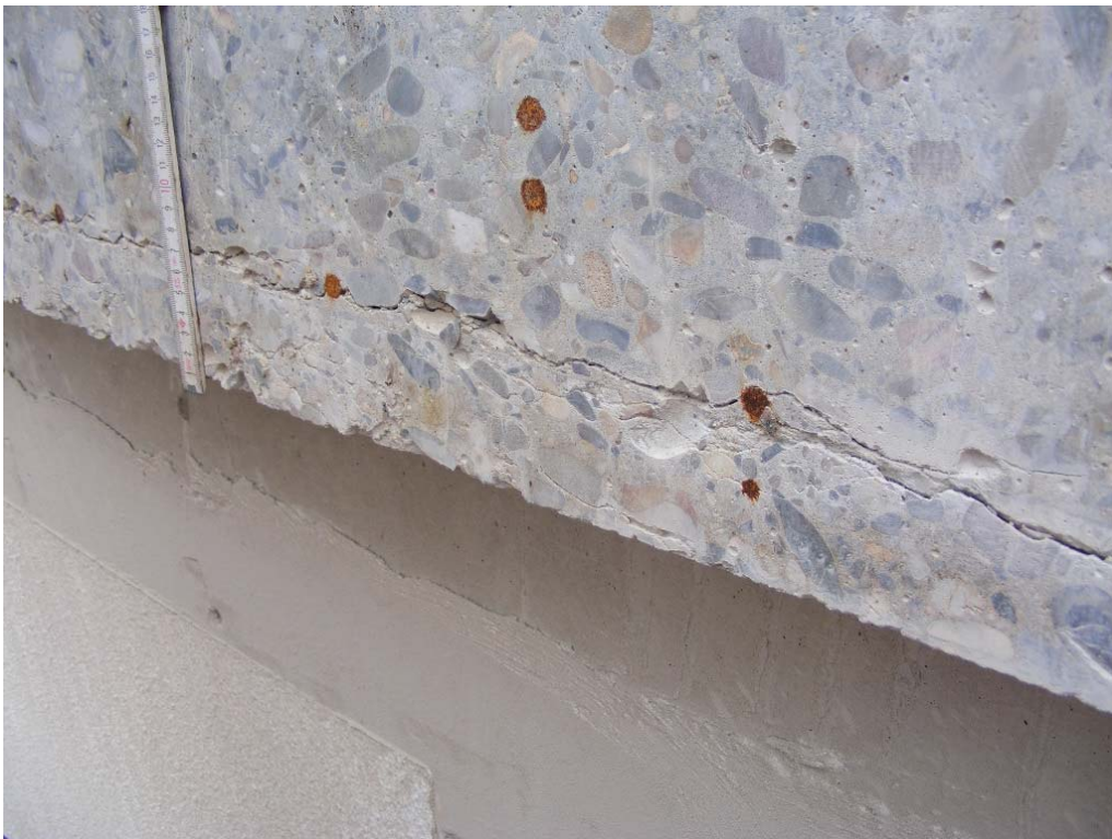
Foto 19: 3 e verdieping, tussen as a en c.
