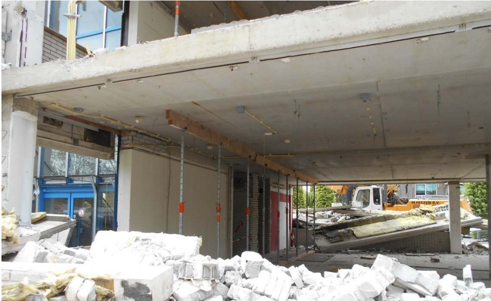
Foto 1: Rij stempels naast as 14 op de onderste bouwlaag (foto 9-5-2017) [13].
