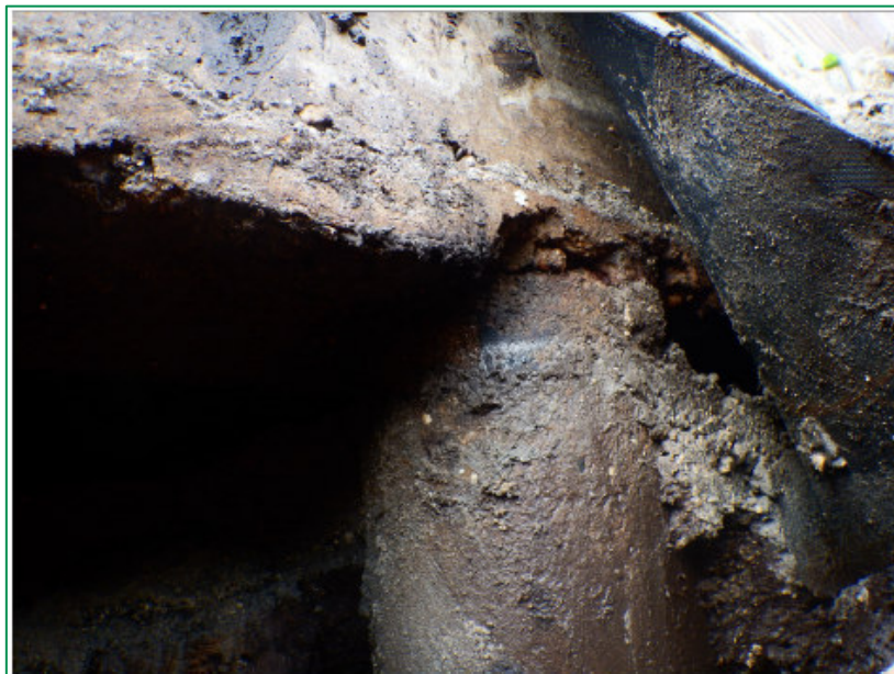
Afbeelding 5: Foto van de uitgevoerde paalinspectie in Zegveld
