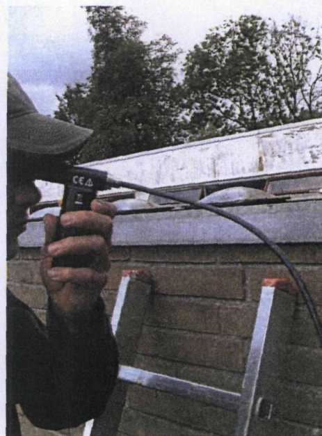
Links: geschikt bevonden spouwgaten die toegang verschaffen tot de binnenkant van de spouw Rechts: Controle van de binnenkant van een spouw met behulp van een endoscoop
