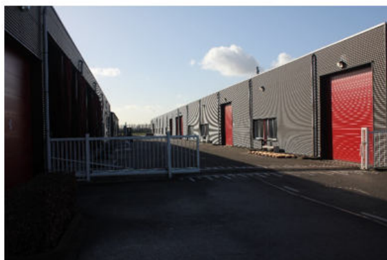
Tussen bedrijfshallen is geen/ onvoldoende ruimte voor vrachtwagenparkeerplaatsen.
