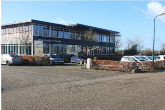
Verweij Houttechniek aan Barwoutswaarder 97.
