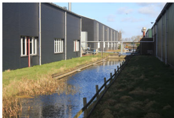
Watergang tussen twee bedrijfsgebouwen.
