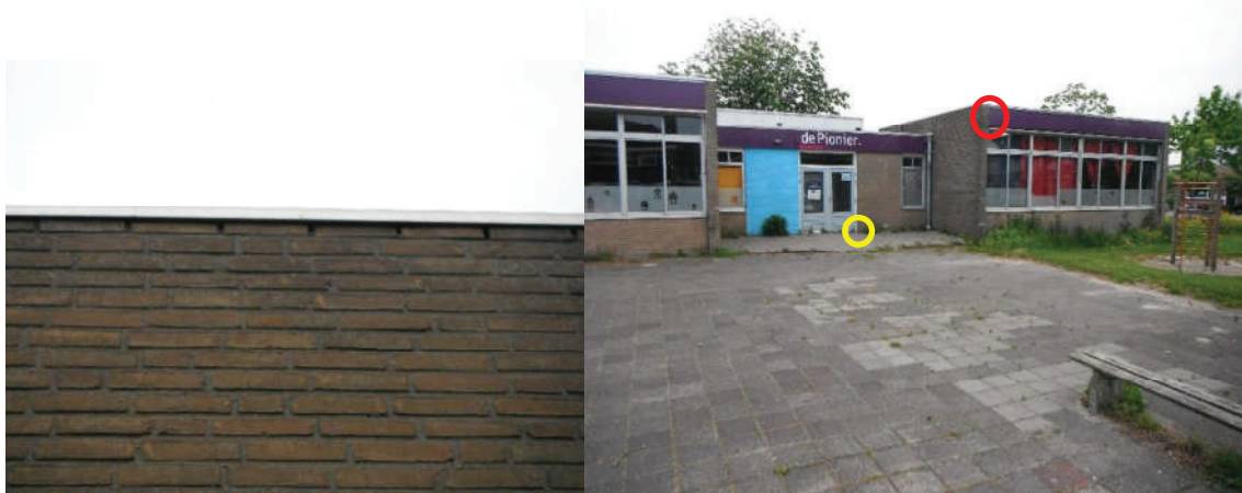
Figuur 3-1. Links een voorbeeld van open stootvoegen die door vleermuizen gebruikt kunnen worden om verblijfplaatsen in de spouwmuur te bereiken. Rechts een tijdens het eerste vleermuisonderzoek aangetroffen invliegopening (circa 10-15 invliegende vleermuizen, rood omlijnd) en de locatie waar rugstreppad is waargenomen (geel omlijnd).
