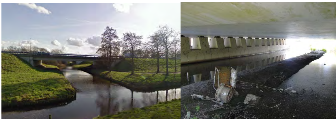
Figuur 4-6. Links: De huidige onderdoorgang bij de A12 betreft een kale, beschoeide oever en is zodoende geen aantrekkelijke locatie voor soorten als de ringslang en bunzing. Het inrichten van een natuurvriendelijke oever zou hier een goede maatregel zijn. Rechts: het aanbrengen van een geleidende structuur (zoals een stobbenwal) biedt kleine marterachtigen dekking, waardoor de kans op passage van de spoorlijn vergroot wordt.
