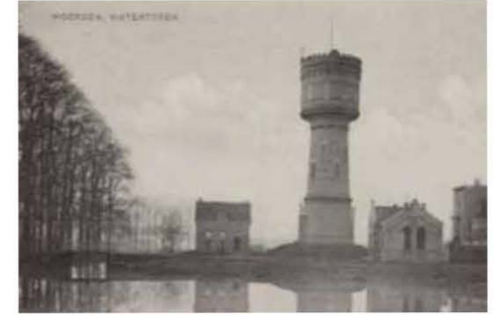
Watertoren omstreeks 1920 . Watertoren in het open, aan de buitenkant een bomenlaan?
