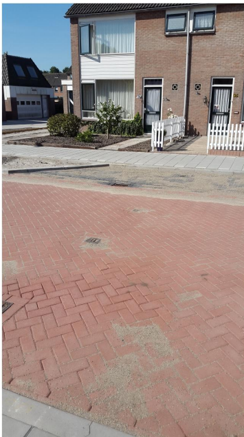
Figuur 3.1: Verdiept geplaatste zakbaken afgewerkt met een straatpot.
