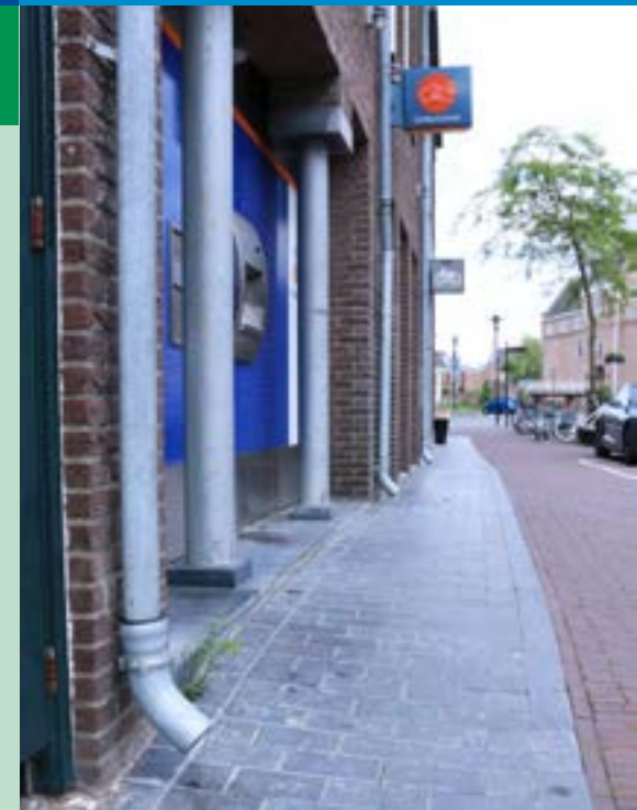
Voorbeeld van bovengrondse afvoer in de Rijnstraat
