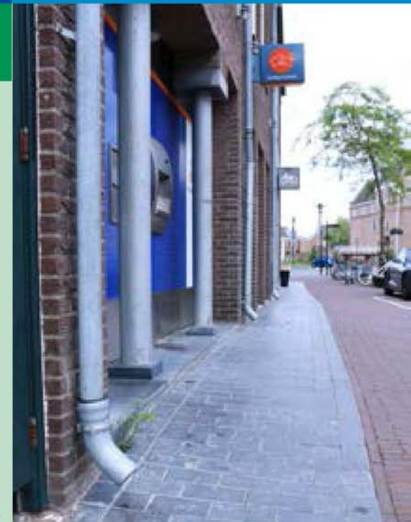
Voorbeeld van bovengrondse afvoer in de Rijnstraat
