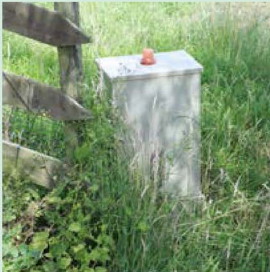
Elektrikast van drukriolering bij een woning. De verzamelput en pomp liggen ondergronds.
