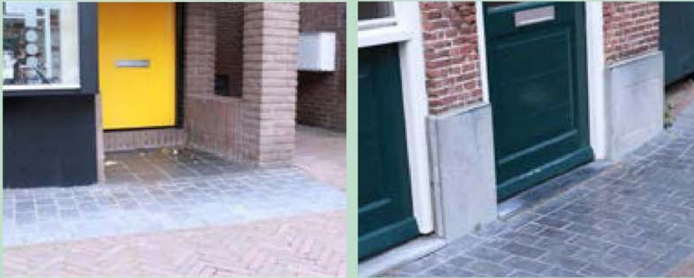
Verschillende vloerpeilen/drempels in de Rijnstraat. Hoe hoger de drempel hoe kleiner de kans op instromend regenwater.
