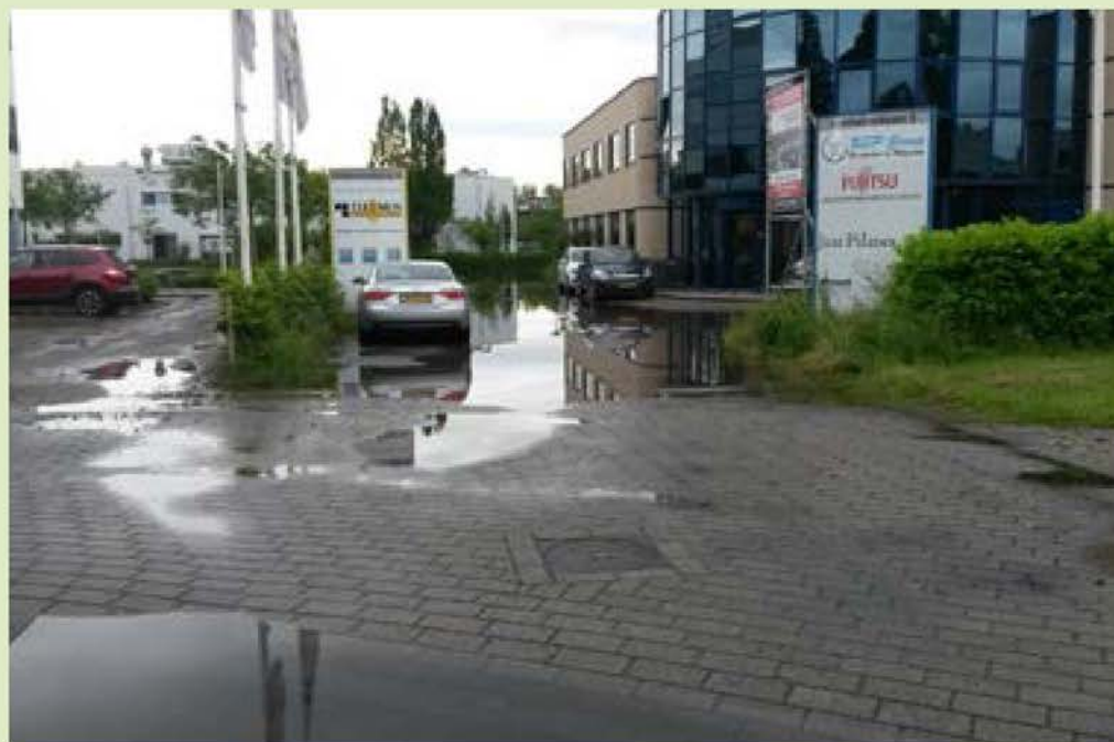
Water op straat op bedrijfspercelen in Middelland
