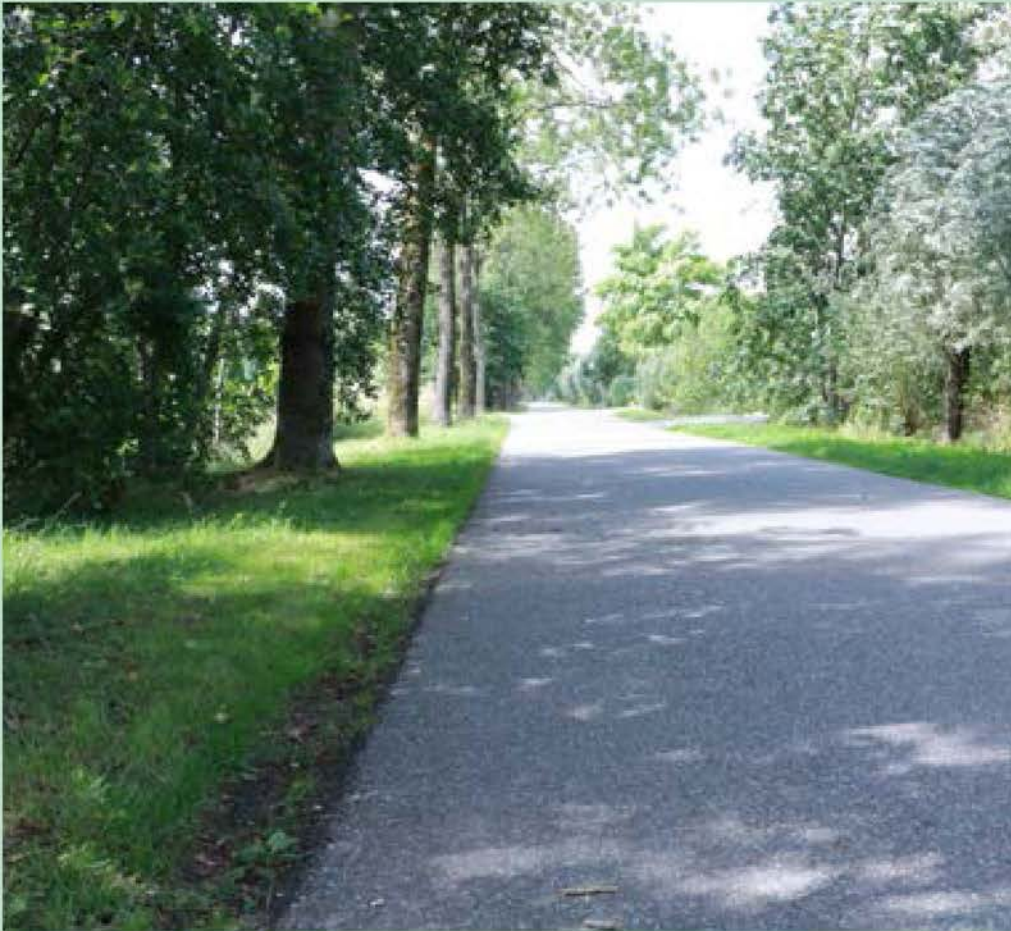
Weg die via de berm afwatert
