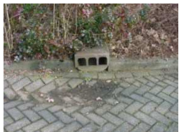
instroming hemelwater wordt belemmerd
