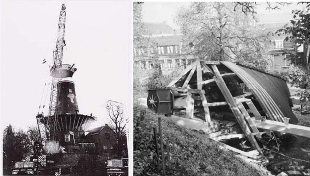
15. De kap wordt van de molen gelicht, 1978. Collectie RHC Rijnstreek, Woerden, nr. W2122.
