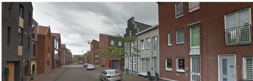
Figuur 48: Voorbeeld van een erftoegangsweg in de wijk Watterrijk. Bron: Google Maps
