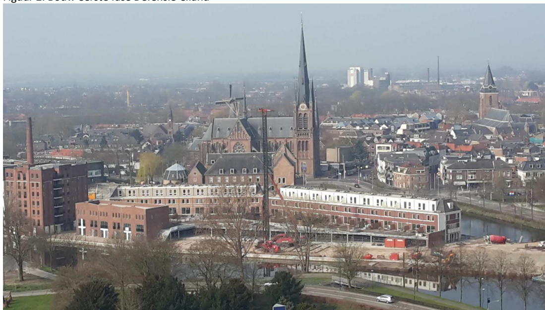
Figuur 2. Bouw eerste fase Defensie-eiland
