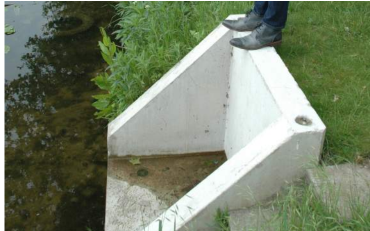
betonnen uitstroomvoorziening
