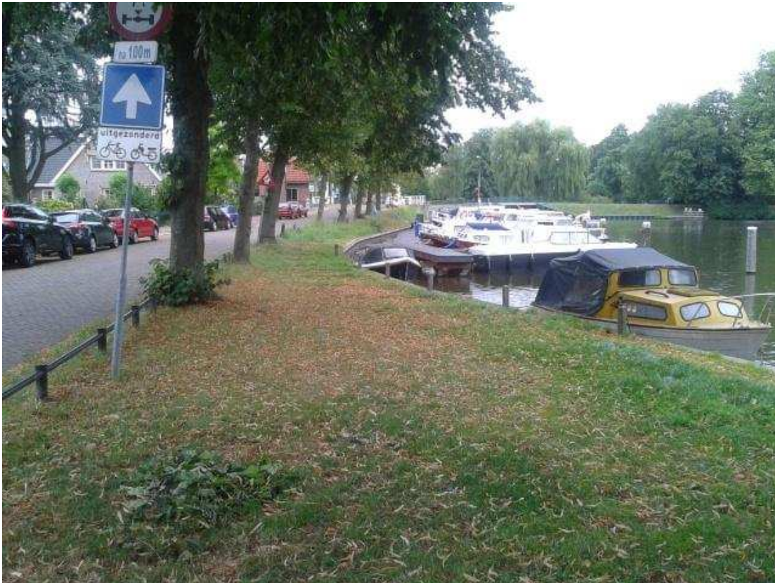
Foto 1 Hoogte boten gezien vanaf verbrede graskant ter hoogte van de Prinsenlaan
