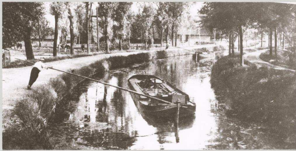
Kleivletten op de Korte Linschoten. Tot in de jaren '40 werd de klei voor de pannen- en steenfabrieken in Woerden van land uit de omgeving afgegraven. Kleivletten voeren af en aan met schuiten die beladen waren met klei
