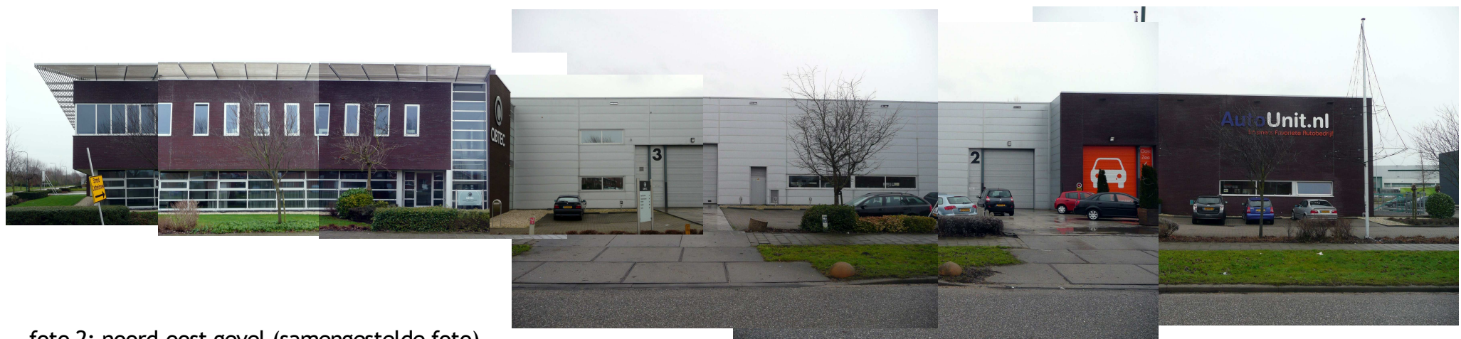
foto 2: noord-oost gevel (samengestelde foto)
