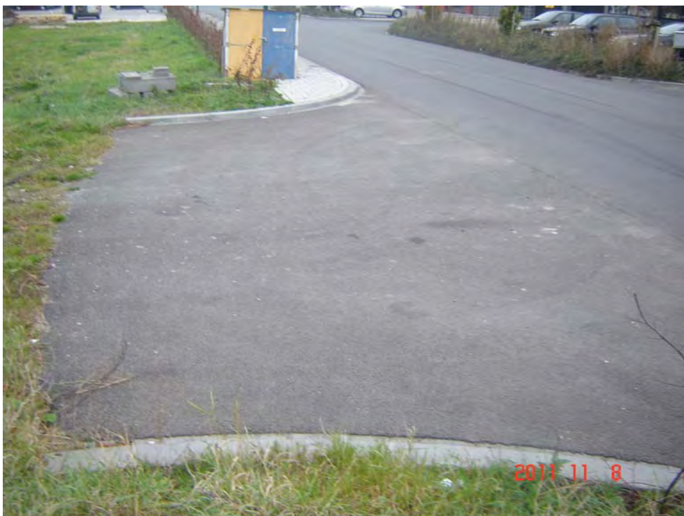
Foto 8 (asfalt op locatie)
