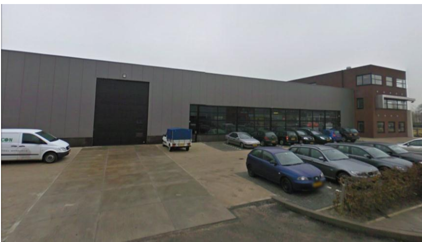
Afbeelding 3: Huidig bedrijfsgebouw Revicon
