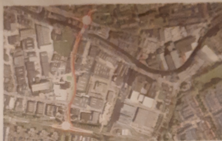
▲ Bovenin de aan te leggen rotonde bij de Rembrandtlaan. Over het water gaat de weg over Barwoutswaarder naar een volgende rotonde bij de Hollandlaan. FOTOGEMEENTE WOERDEN
