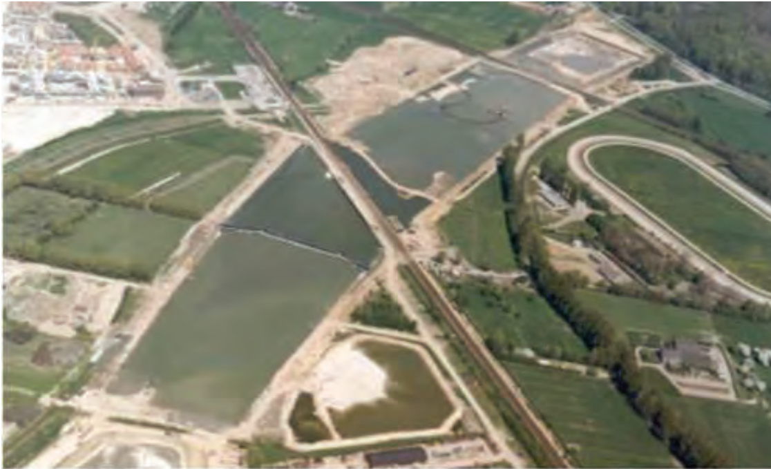
Figuur 16. Folieconstructie A27 (bron: RWS) 34 .
