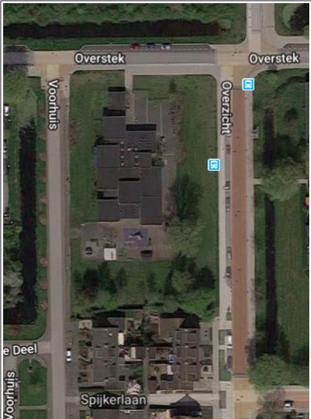
Figuur 5 – Bestaande locatie Overstek 1 in Kamerik op een luchtfoto (Bron: GoogleMaps)
