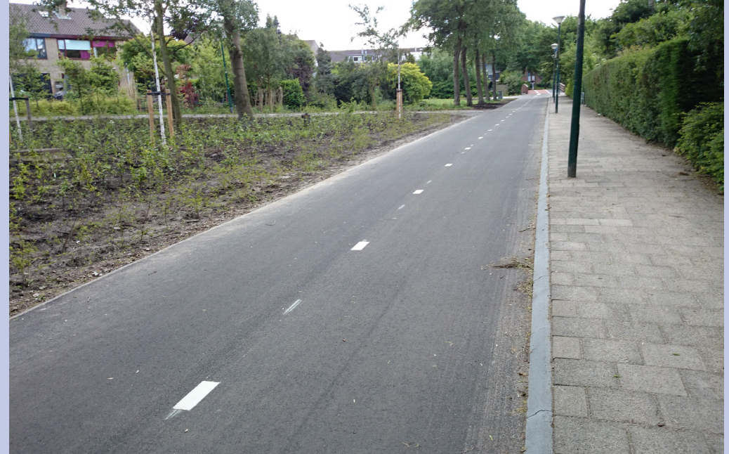
Fietspad met voldoende breedte voor het gebruik door hulpdiensten
