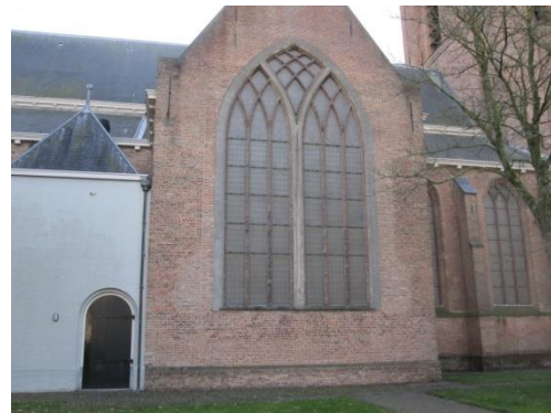
illustratie 9: Dwarsschip van de Petruskerk. Links en rechts van het venster zijn bouwsporen te zien
