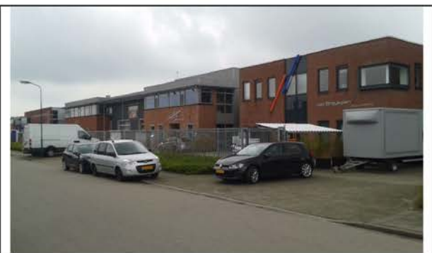
Overlast door 'andere' activiteiten
