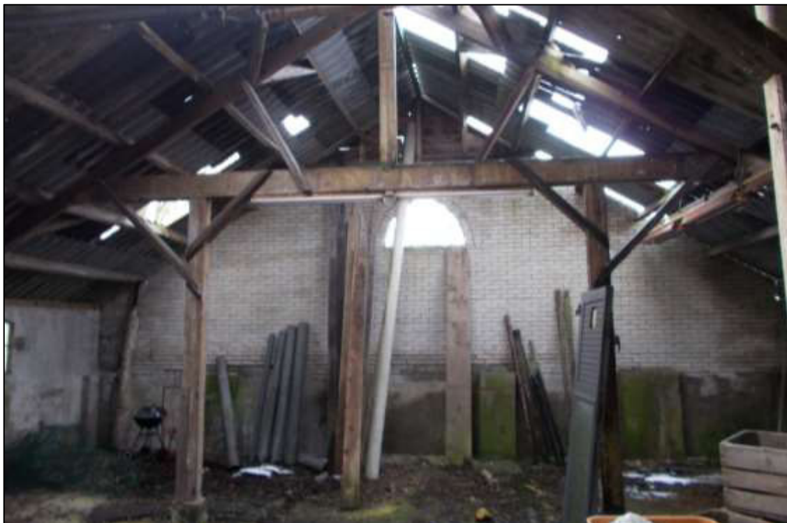
Figuur 13: Dwarsbalken in de schuur vormen mogelijk geschikte zitposten voor uilen. Deze kunnen eenvoudig bereikt worden via vele openingen in het dak.
