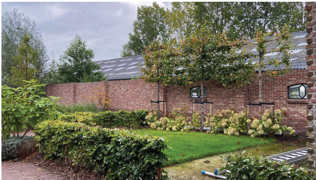
Figuur 13: oorspronkelijke, bestaande tuinmuur op de oostelijke perceelsgrens
