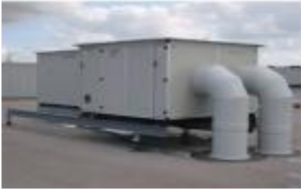
Gebalanceerde mechanische ventilatie middels een centraal opgestelde luchtbehandelingskast op het dak.
