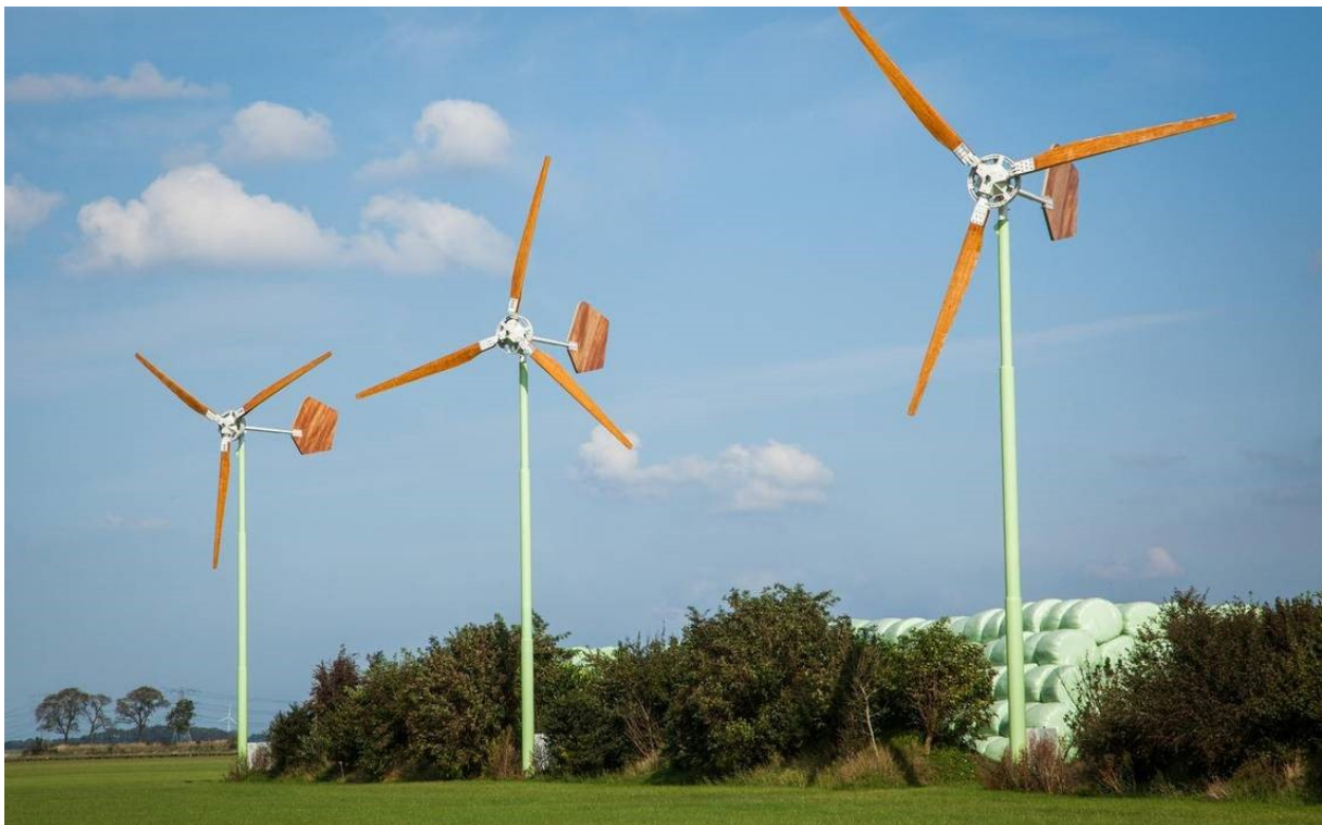
Voorbeelden EAZ wind-twaalf: masthoogte 15m, tiphoogte 21m (bron: Onderzoek kleine windturbines, Bosch en van Rijn 2018)
