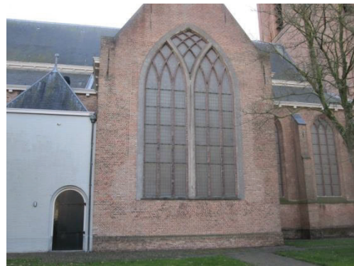
illustratie 9: Dwarsschip van de Petruskerk. Links en rechts van het venster zijn bouwsporen te zien
