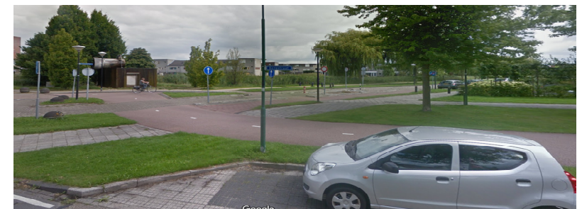
Aansluiting fietspad op de Bergstraat langs trafo/gemaalhuis
