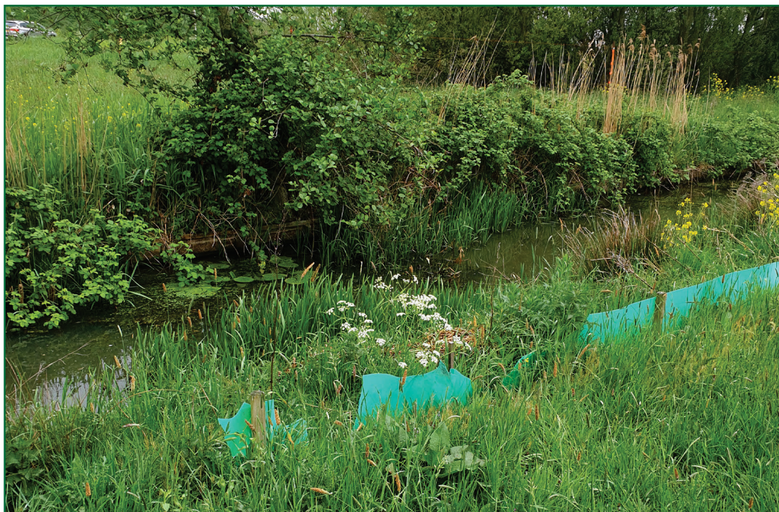
Afbeelding 4: Het huidige faunascherf is op een aantal plaatsen beschadigd (2020). Hierdoor is de functionaliteit aangetast. Het is noodzakelijk de beschadigingen ter herstellen vóór afloop van de winterrust van beschermde amfibieën. Bron; Ruimte voor Advies 2020
