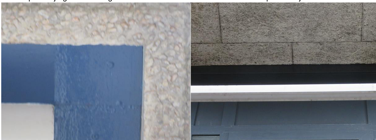
Fig. 5: naadloze aansluiting van beton op kozijnen.
