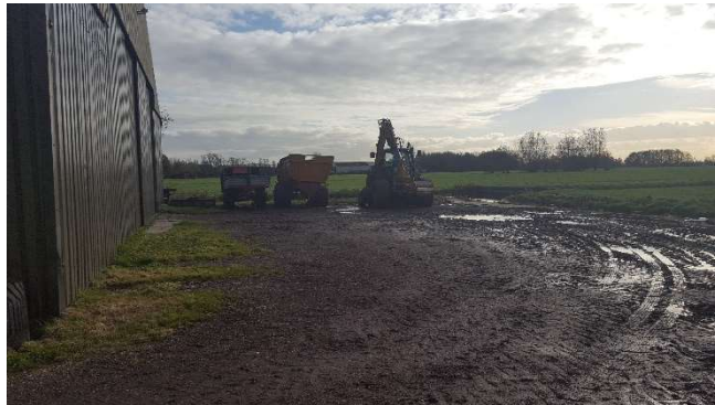
Foto linksboven: zuidwestelijke kopgevel
