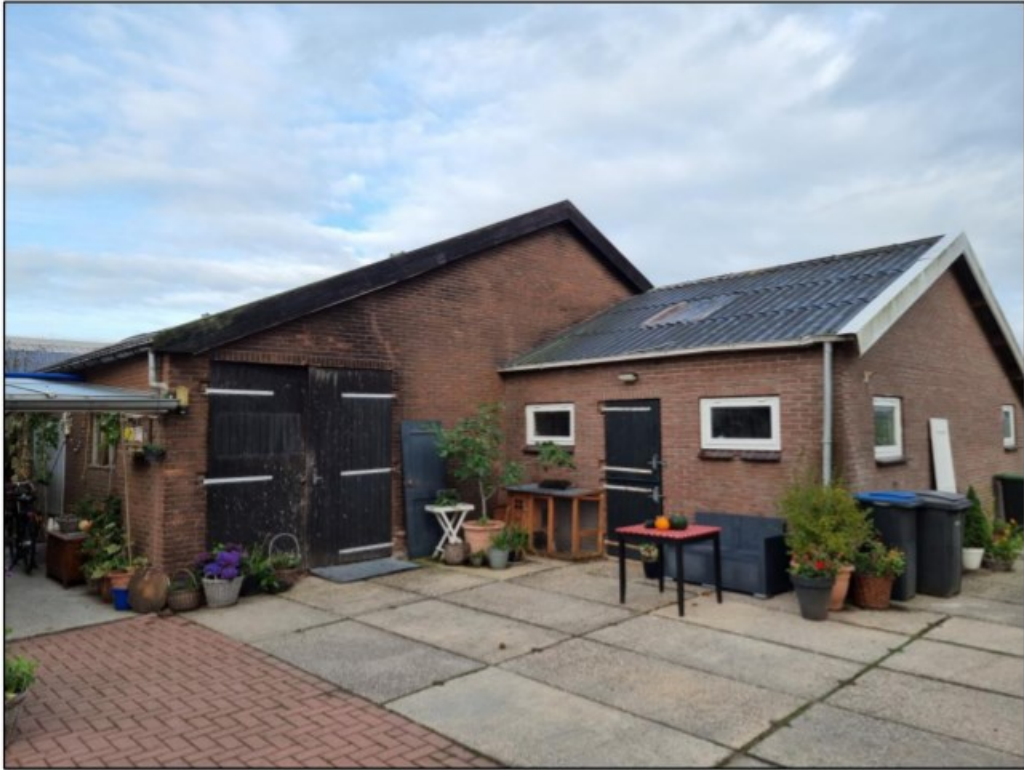
Figuur 3 De te saneren stallen zijn opgetrokken uit gemetselde muren met golfplaten zadeldaken.
