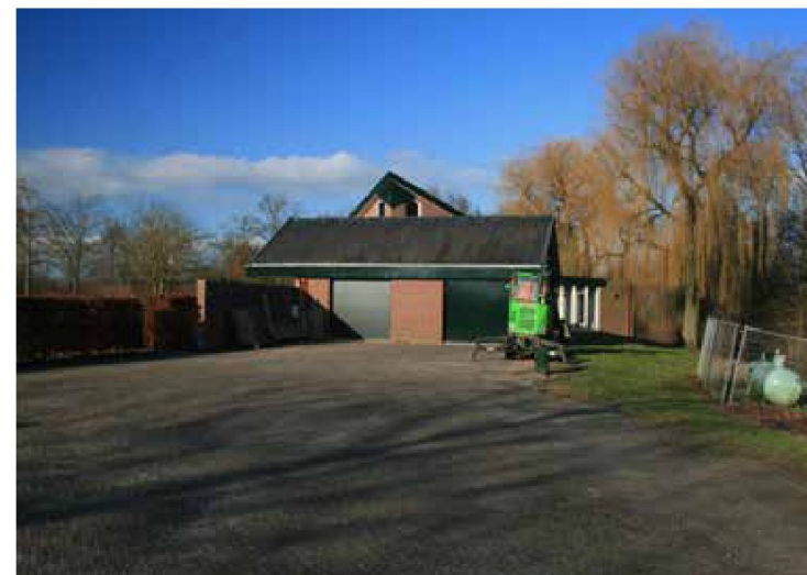
Figuur 21. Opslagruimte met gastank voor verwarming gebouwen.
