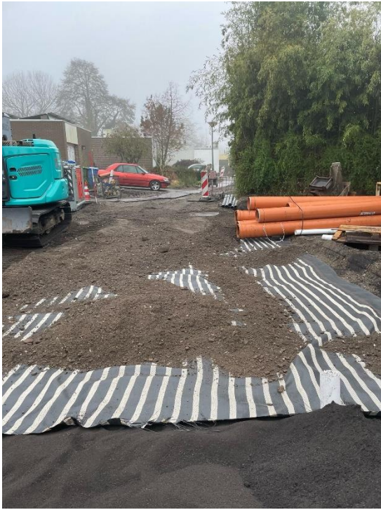
Argex zand (zwart), scheidingsdoek (zwart wit gestreept) en bovenop het menggranulaat.
