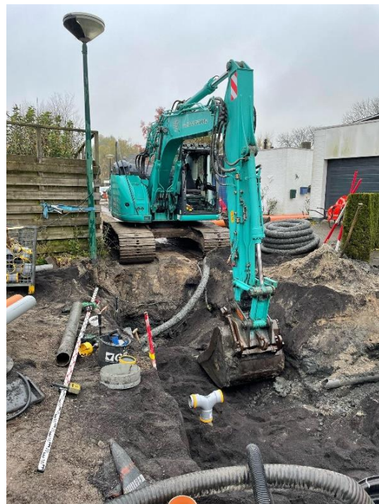
Aanleggen schoon (HWA) en vuilwater (DWA) riolering en drainage
