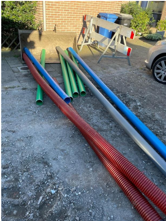
Mantelbuizen kabels en leidingen
