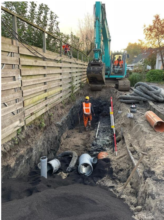
Aanleggen schoon (HWA) en vuilwater (DWA) riolering en drainage
