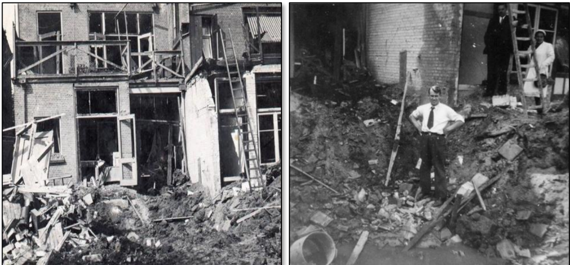
Afbeelding 5: schade ontstaan tijdens de bombardementen op 11 juli 1940 en 11/12 juli 1940. Bron: https://izi.travel/nl/05f9-bombardement-stationsweg/nl .
