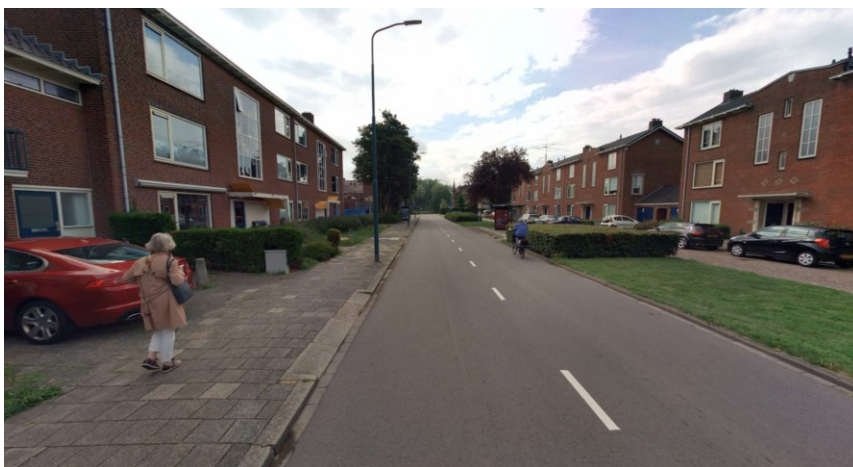
Figuur 15: Huidige situatie Rembrandtlaan oostzijde richting Zandwijkstraat (bron: Cyclomedia)
