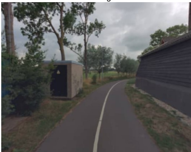
Figuur 15: : Huidige situatie fietspad achter Stoomgemaal (bron: Cyclomedia)
