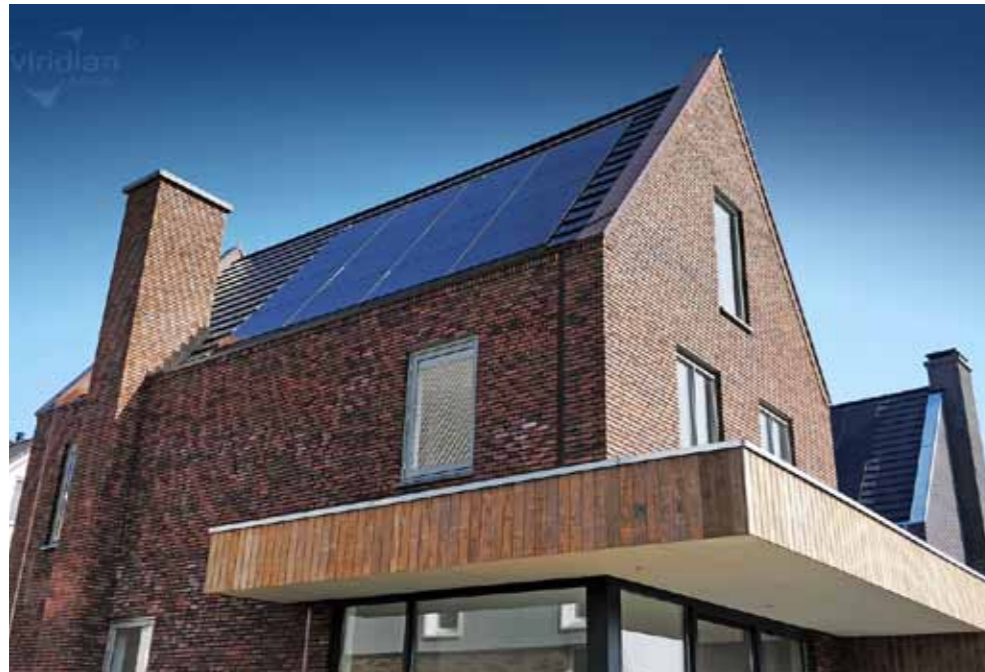
pv-panelen geïntegreerd in de vormgeving van het dak
