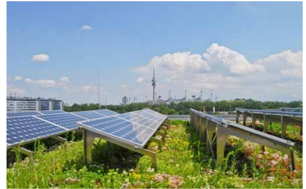
pv-panelen krijgen een verkoelende werking i.c.m. groen op het dak
