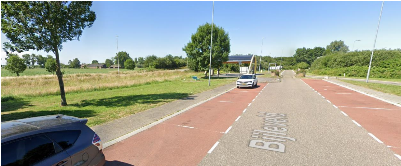
Afbeelding 3.2: Bestaande situatie van het plangebied gezien vanaf het verzorgingsgebied Bijleveld (bron: google maps)
