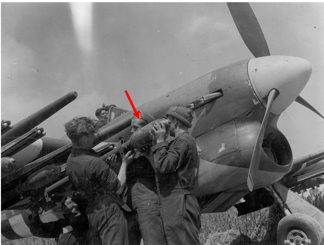
Figuur 23: Een 60 lb. raket wordt bevestigd aan een Hawker Typhoon. De gevechtskop is goed te zien (zie rode pijl). Bron: Wikimedia.
