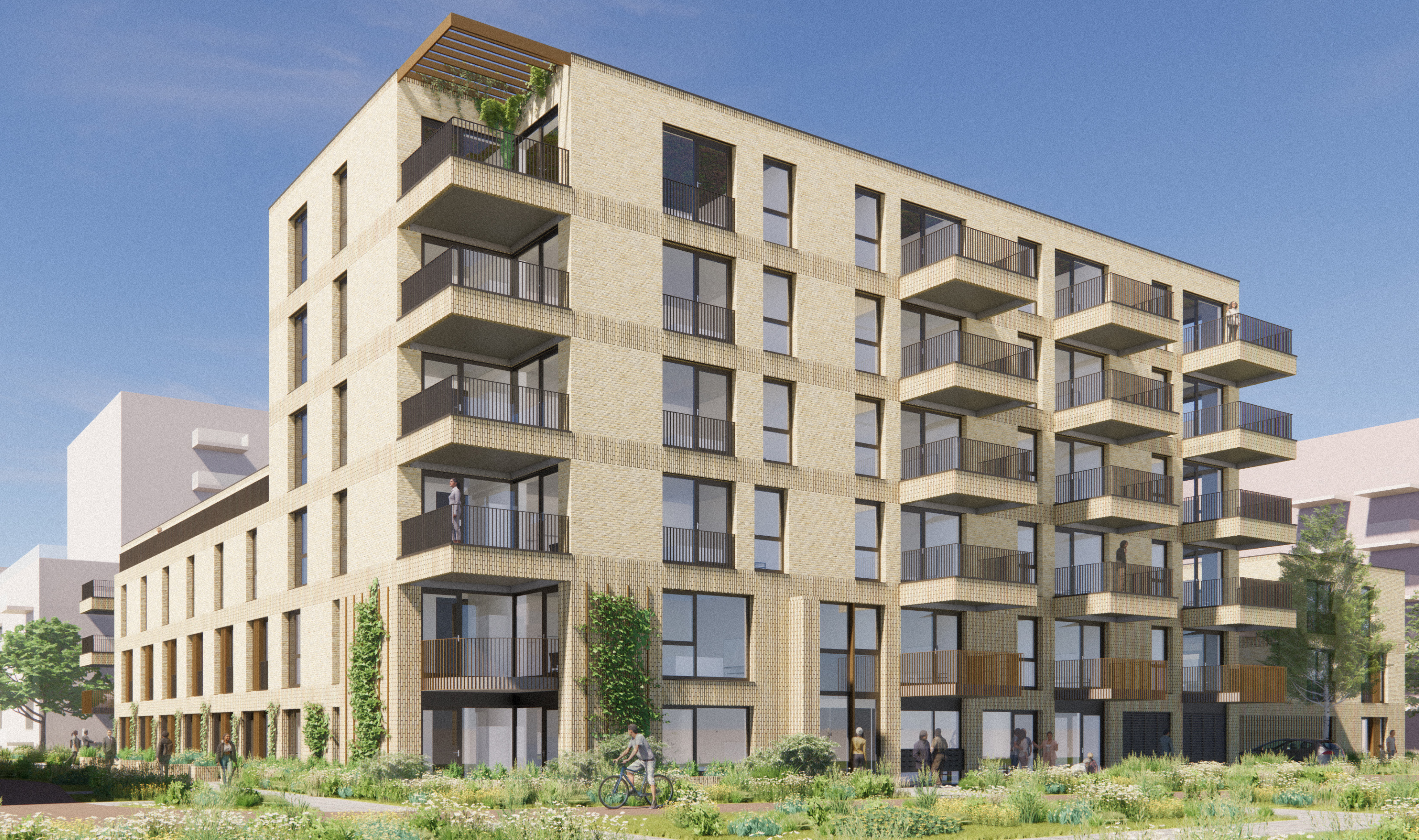
BALKONS ALS RUIMTELIJK ACCENT OP DE KRUISING VAN DE ZAAGMOLENLAAN EN DE WATERMOLENLAAN
