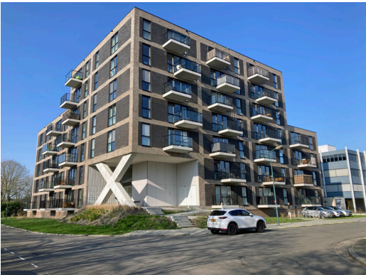
THE MILL AAN DE OOSTZIJDE VAN DE WATERMOLENLAAN
