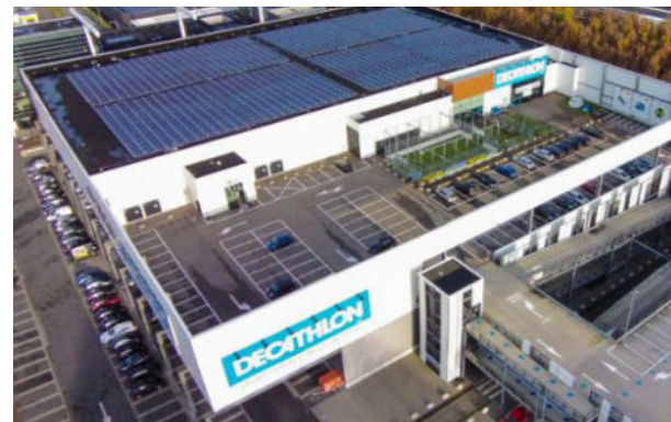
Parkeren op het dak achter gevel. NB. opgang is hier zichtbaar buiten hoofdvolume. Dit is niet toegestaan in de Voortuin. ✓
