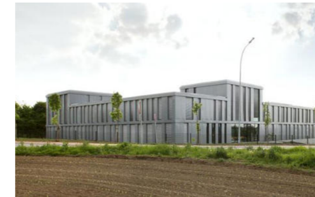
Eenduidige gevelinvulling, verticale geleding, omlopende gevel maar sprongen in daklijn.
