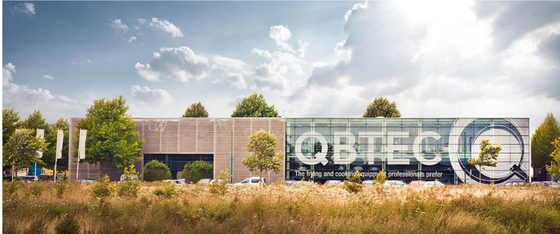
Figuur 41. Referentiebeeld reclame op de gevel
