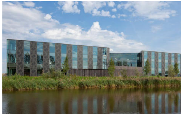
Verticale geleding, uniform gevelbeeld, variatie in lange gevel door subtiele inkeping. Eenduidigheid volume blijft intact.
