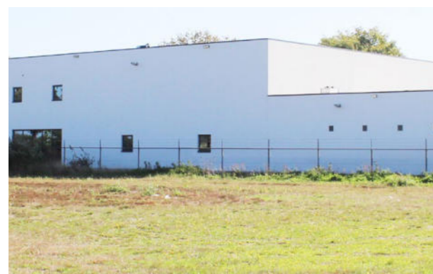
Hekwerk direct voor de gevel is niet toegestaan
