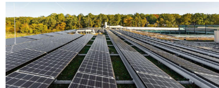
Groen dak gecombineerd met zonnepanelen
